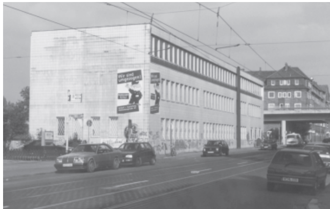
Das leerstehende Haupthaus von ehemals Marquardt & Schulze
